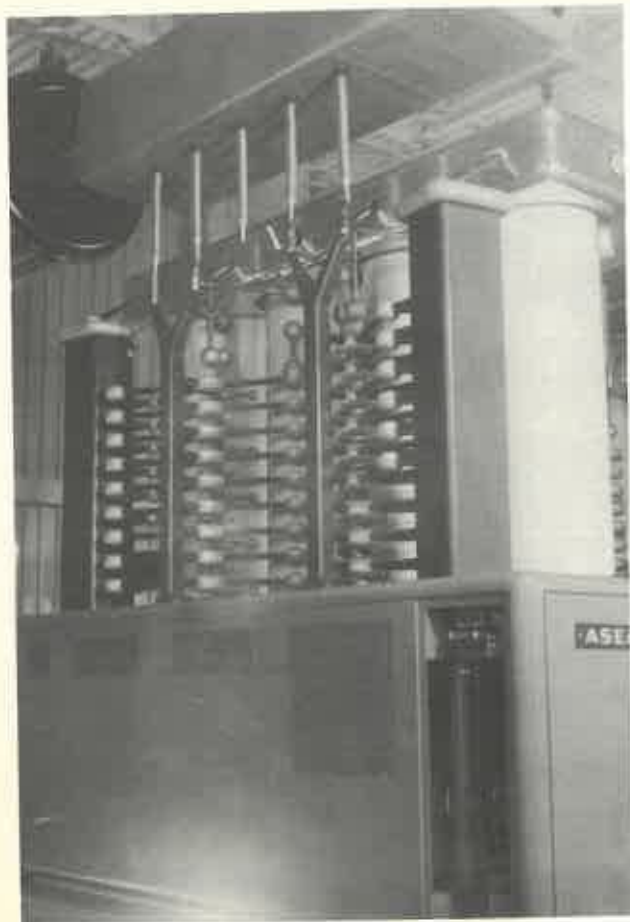
▲水銀整流器側面および分流器
