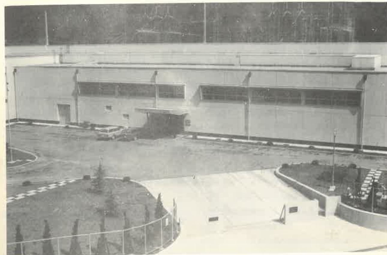
▲正面玄関全景
