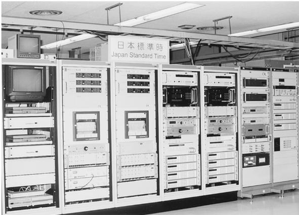
図1 セシウム原子時計を基に日本標準時を生成する装置 (NICT@小金井市)
