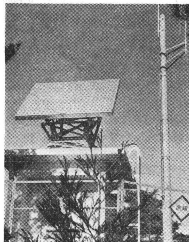
第 10 図 太陽電池を電源とした信 夫山無人中継局
