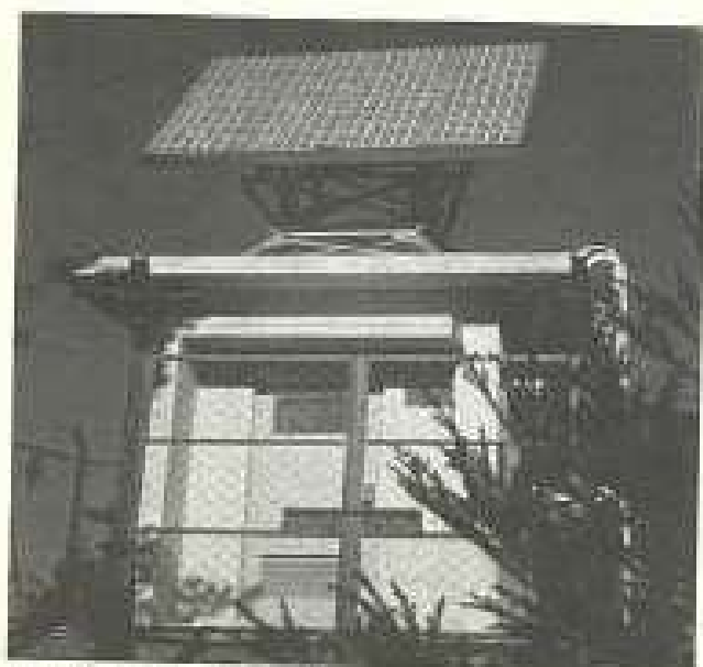
写真2-8 日本で最初に実用化された太陽電池 応用通信システム「東北電力信夫山無線中継所」 （写真提供：武蔵もも子氏）
