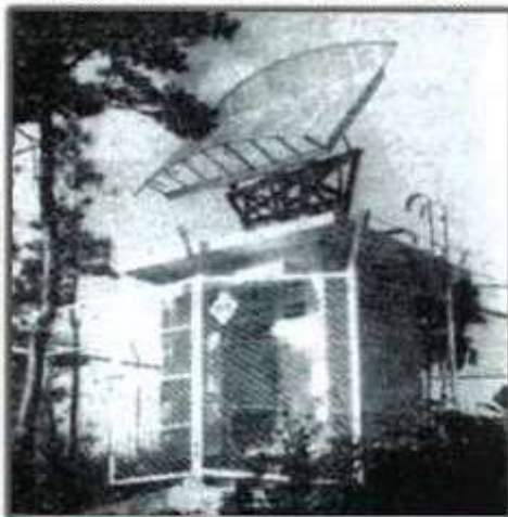
福島市信夫山に建設された日本初の太陽光発電によるロボット無線中継局。局舎には、火災・盗難・風雨に備えるため、鉄筋コンクリートが採用された。
