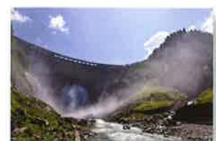
黒部川第四発電所 Kurobe River No. 4 Hydropower Plant
