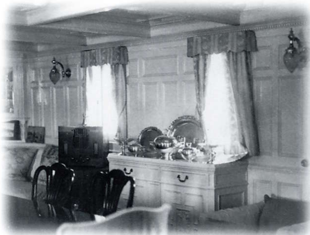
Elegante sala interna dell' Elettra dopo la ristrutturazione
